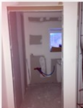
Détail Chambre Appartement 1
